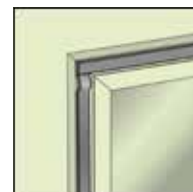
Eckauslage bei der Fenstermontage
