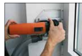
Fenster - Demontagemaschine im Einsatz, mit Staubabsaugung
