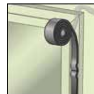
Stumpfstoß bei der Fenstermontage
